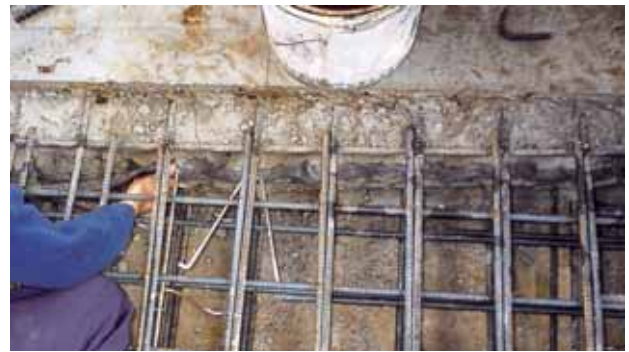
● スラブ打継部
