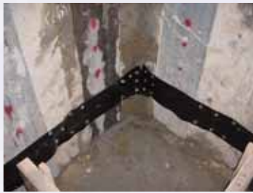
④ 入隅部及び接合部は多めに釘打ち
