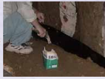
③ 釘打ちで固定(mあたり10~15本が目安) なるべく凹凸に追従させて設置
