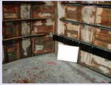
② 入隅部にロールの端部がくる ように設置
